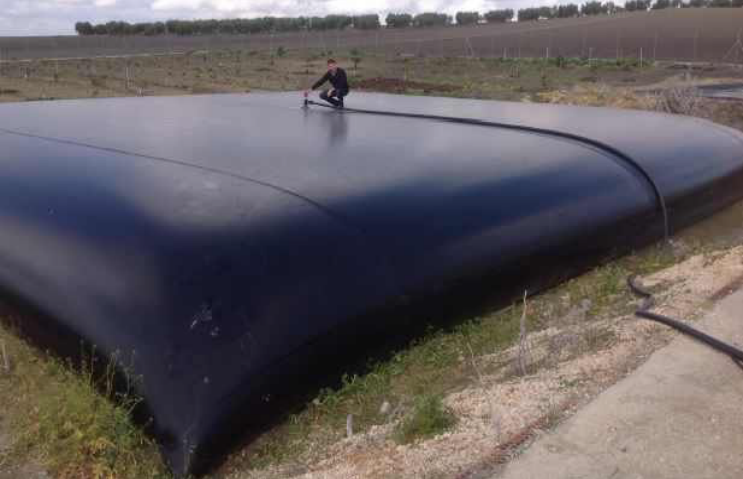
Depozite contra incendiilor
